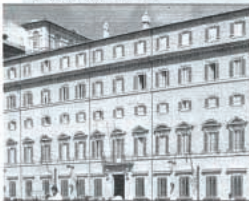
Palazzo Caviglioglio (progettazione)
